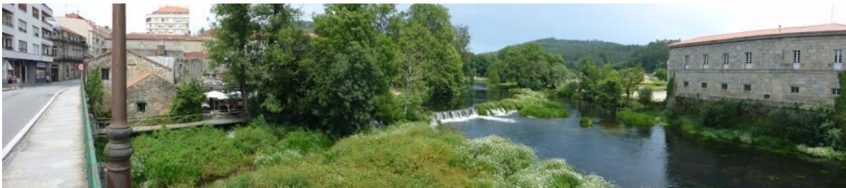
Abbildung 40: Brücke über den Rio Umia in Caldas de Reis
